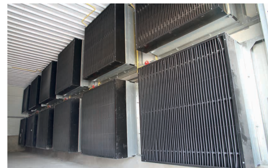
Светофильтры, установленные на вентиляторы, могут снизить их производительность и не являются лучшим вариантом в тоннельных птичниках с высокой скоростью воздуха.
