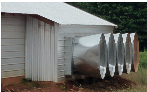
Светофильтры на тоннельных вентиляторах, установленные в фальш-стене помещения пленумного типа перед тоннельными вентиляторами по боковым стенам птичника.
