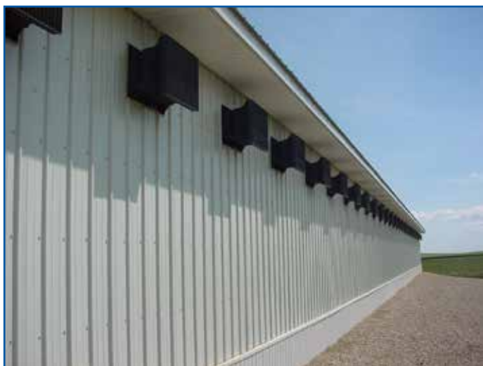
Рис. 119: Пример светозащитных жалюзи на приточных форточках перекрестной вентиляции.
