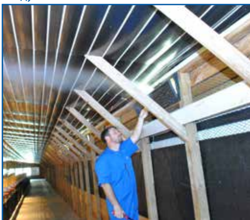
Рис. 106: Применение дымовой шашки для определения эффективности рабочего давления в птичнике и воздушного потока.
