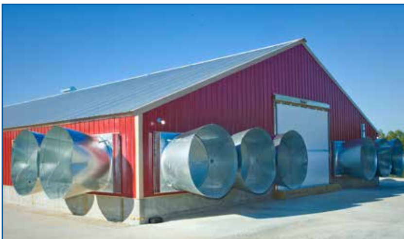
Рис. 112: Пример птичника, оборудованного туннельной вентиляцией.
